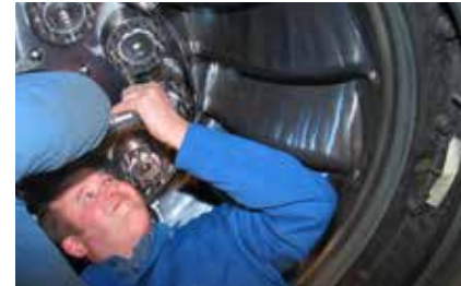
Устройства натяжения Superbolt позволяют проводить монтаж болтовых соединений даже в самых неудобных положениях и в ограниченных пространствах. Соединение рабочего колеса турбины с валом с применением устройства MJT позволило удовлетворить требования по регулярному техническому обслуживанию рабочего колеса.
